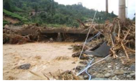
Şekil 1. Doğu Karadeniz Havzası'nda taşkın anında biriken rüsubi malzemenin köprü vb. yapıların kesitlerini tıkaması
