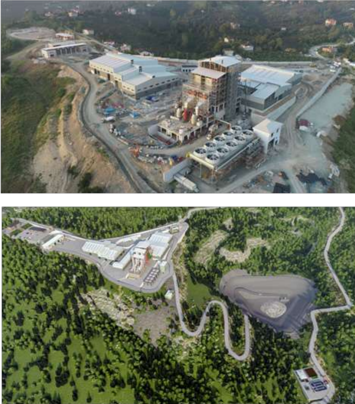
Şekil 9. Trabzon-Rize illeri katı atıklarının bertarafı için Taşönü'nde (Araklı, Trabzon) inşa edilen "Entegre Katı Atık Değerlendirme ve Bertaraf Tesisi"
