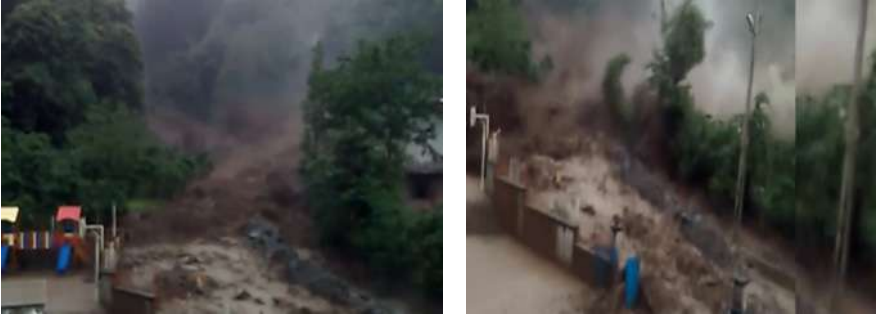
Şekil 5. Heyelan sonucu oluşan gölün patlaması sonrasında meydana gelen taşkın
