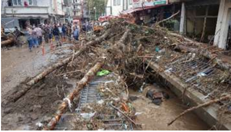
Şekil 1. Doğu Karadeniz Havzası'nda taşkın anında biriken rüsubi malzemenin köprü vb. yapıların kesitlerini tıkaması
