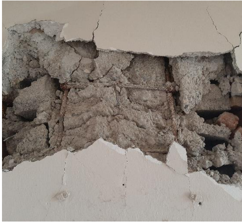
Şekil 48. 23 Kasım 2022 Gölyaka (Düzce) depreminde tespit edilen yetersiz enine donatı kullanımının neden olduğu hasarlar
