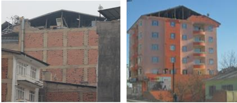
Şekil 57. (a) 24 Ocak 2020 Sivrice (Elazığ) [16] ve (b) 9 Kasım 2011 Van [22] depreminde tespit edilen kalkan duvar hasarları
