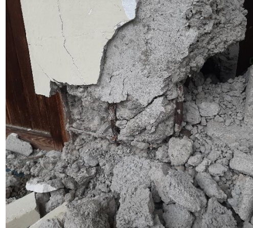
Şekil 48. 23 Kasım 2022 Gölyaka (Düzce) depreminde tespit edilen yetersiz enine donatı kullanımının neden olduğu hasarlar
