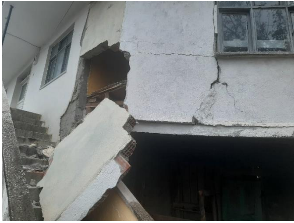
Şekil 43. 23 Kasım 2022 Gölyaka (Düzce) depreminde oluşan zayıf dolgu duvar hasarları
