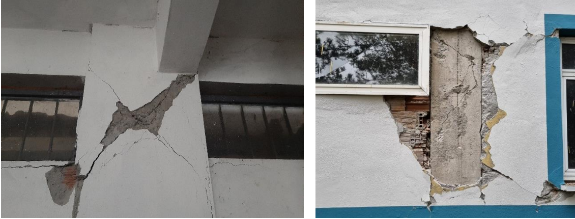
Şekil 32. 23 Kasım 2022 Gölyaka (Düzce) depreminde tespit edilen kısa kolon oluşumundan kaynaklı yapısal hasarlar
