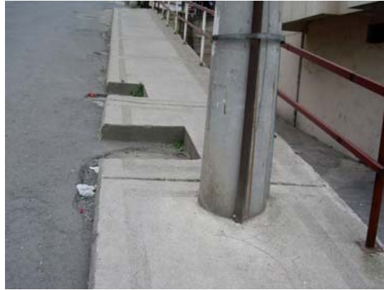
Şekil 153. Kaldırım üzerine yerleştirilmiş geçişi engelleyen teknik alt yapı elemanları
