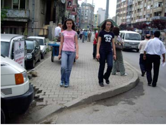
Şekil 101. Sürekliliği olmayan kaldırımlar 1
