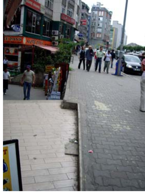
Şekil 105. Seviye farklılıklarının olduğu yerlerde koruyucu korkuluk düzenlemesinin olmaması
