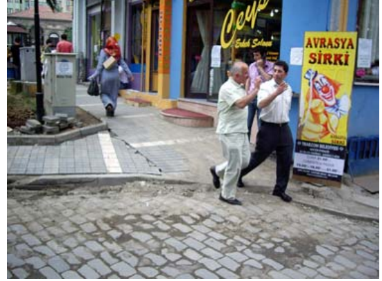
Şekil 102. Sürekliliği olmayan kaldırımlar 2
