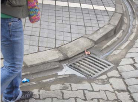
Şekil 164. Yaya yollarında ve kaldırımlarda kullanılan ızgaraların açıklıkları, yerleştiriliş biçimleri uygun değil
