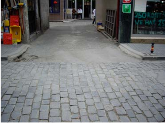
Şekil 118. Ölçüleri ve yüzey dokusu kullanılama uygun olmayan kaldırım rampaları 1
