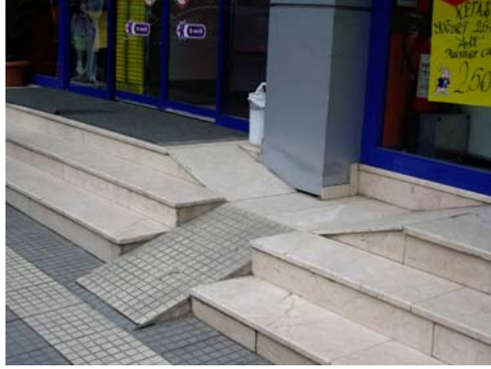
Şekil 121. Ölçüleri ve yüzey dokusu kullanılamaya uygun olmayan rampalar 1
