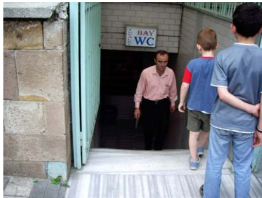
Şekil 160. Tekerlekli sandalye kullanan bedenssel engelliye uygun tasarlanmamış umumi tuvaletler 1
