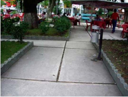
Şekil 147. Tekerlekli sandalye kullanan bedensel engelliye uygun tasarlanmamış park içi döşemeler
