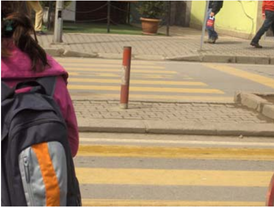
Şekil 132. Yanlış tasarlanmış iki kademeli geçiş düzenlemesi 1
