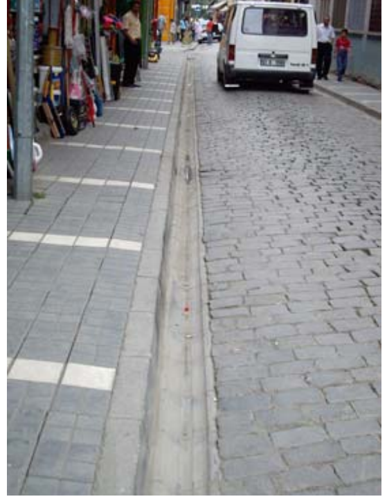
Şekil 152. Kaldırım kenarına üstü açık olarak yerleştirilmiş geçişi engelleyen teknik alt yapı elemanları
