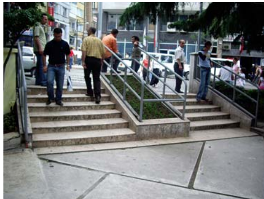
Şekil 145. Tekerlekli sandalye kullanan bedensel engelliye uygun tasarlanmamış park girişi 1
