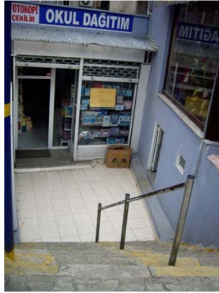
Şekil 174. Alışveriş merkezlerinin tekerlekli sandalye kullanan bedensel engellilerce kullanılmaması 5
