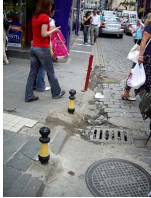
Şekil 117. Yaya alanı üzerinde, araç geçişlerini engellemek için yerleştirilmiş olan ve geçişi engelleyen demirler
