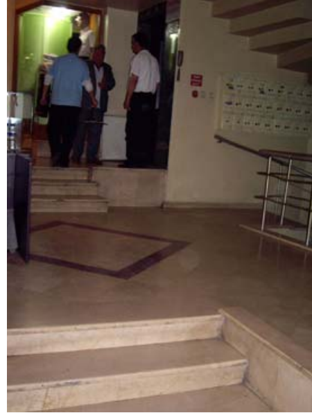
Şekil 177. Alışveriş merkezlerinin tekerlekli sandalye kullanan bedensel engellilerce kullanılmaması 8
