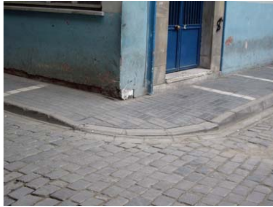
Şekil 97. Yetersiz kaldırım genişliği ve yetersiz dönüş alanı
