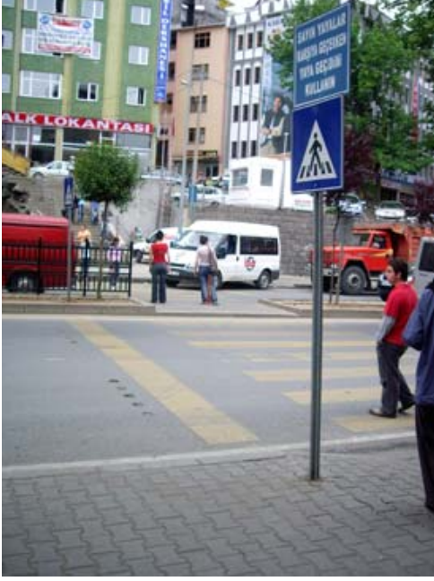
Şekil 134. Yanlış tasarlanmış iki kademeli geçiş düzenlemesi 3
