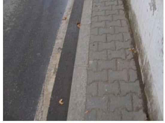
Şekil 96. Yetersiz kaldırım genişli
