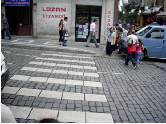
Şekil 140. İniş ve çıkışlarında rampa düzenlemesi olmayan yaya geçitleri
