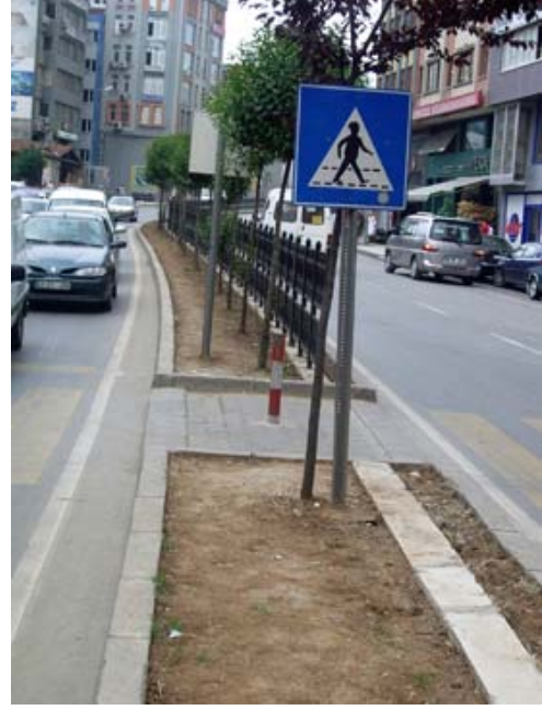
Şekil 135. Yanlış tasarlanmış iki kademeli geçiş düzenlemesi 4
