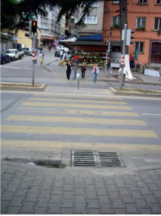
Şekil 151. Altyapı unsurlarının yanlış yer seçiminden kaynaklanan geçiş zorlukları
