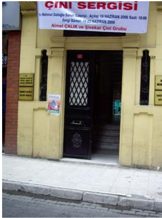
Şekil 197. Kültürel tesis alanlarının tekerlekli sandalye kullanan bedensel engelliler için uygun olmayan girişleri 3
