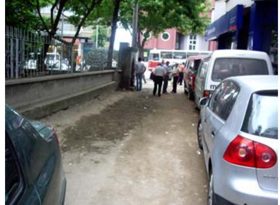
Şekil 205. Alt yapı çalışmaları sonrası onarılmamış yollar 2
