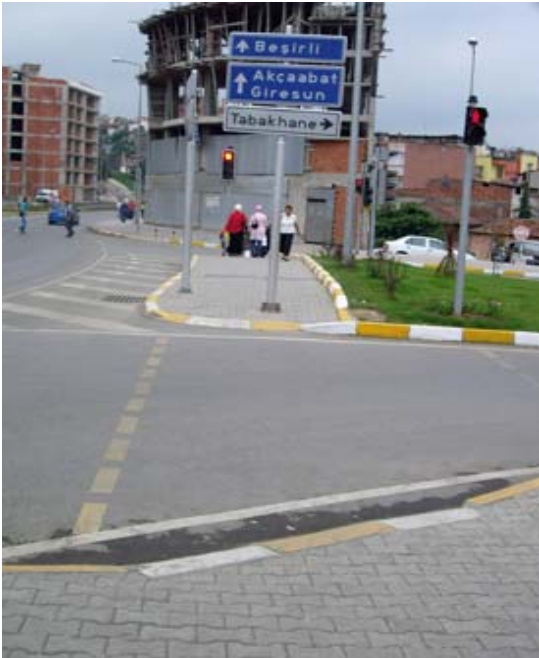
Şekil 168. Yaya alanı üzerinde yer alan tabelaların geçişi engellemesi 1
