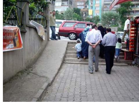
Şekil 125. Ölçüleri ve yüzey dokusu kullanıma uygun olmayan rampa 3
