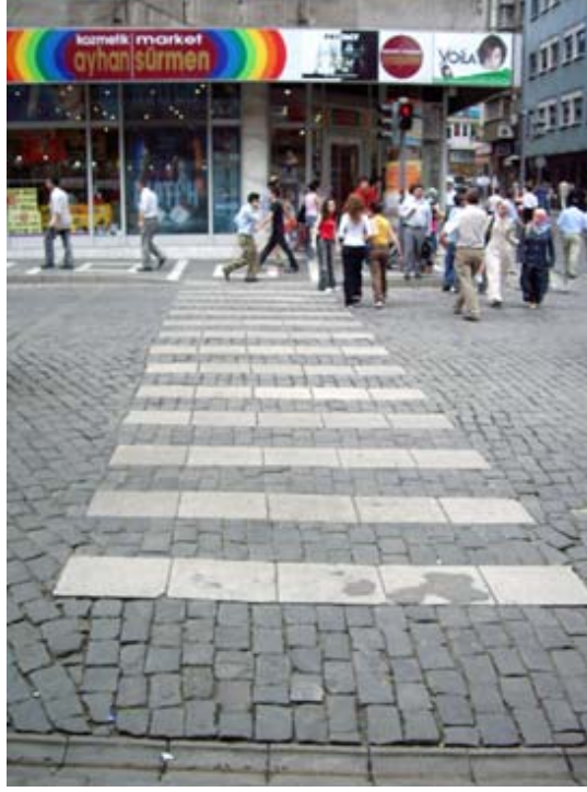
Şekil 131. İki kademeli geçişle düzenlenemeyen yaya geçidi örneği
