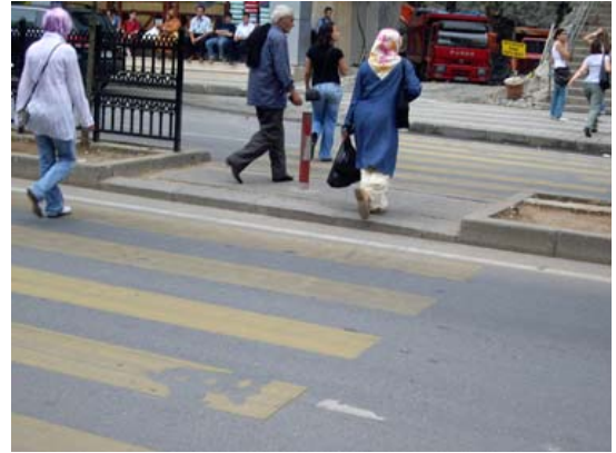
Şekil 133. Yanlış tasarlanmış iki kademeli geçiş düzenlemesi 2
