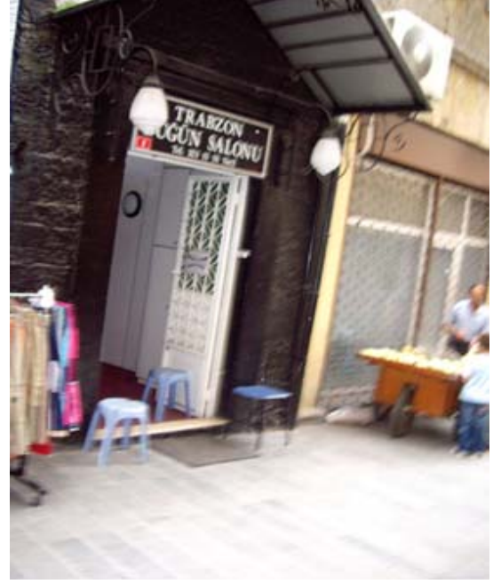
Şekil 199. Tekerlekli sandalye kullanan engelliler için uygun düzenlenmemiş düğün salonu girişi
