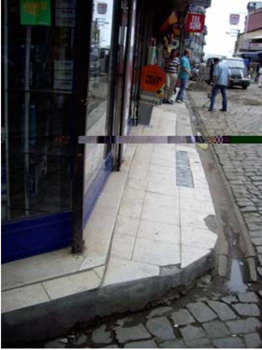
Şekil 99. Yetersiz kaldırım genişliği ve uygun olmayan kaplamalar 2
