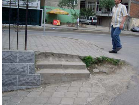
Şekil 103. Sürekliliği olmayan kaldırımlar 3
