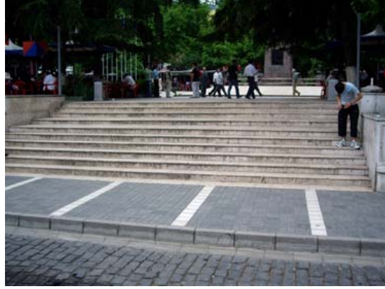
Şekil 146. Tekerlekli sandalye kullanan bedensel engelliye uygun tasarlanmamış park girişi 2
