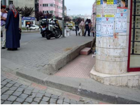
Şekil 106. Kaldırımda tehlike yaratan seviye farklılıkları 1
