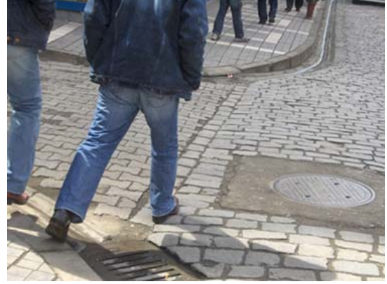
Şekil 165. Hareket yönüyle aynı yönde yerleştirilmiş ızgaralar
