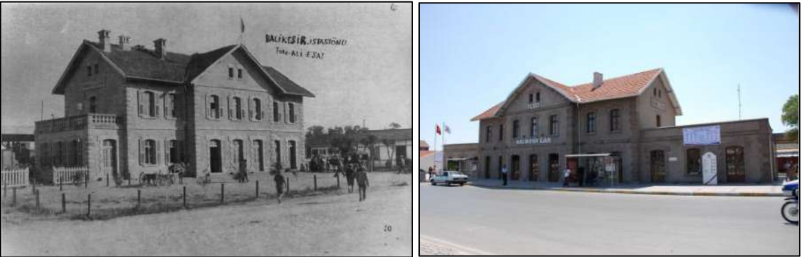
Őekil 52. Balıkesir gar binası fotoęrafı
